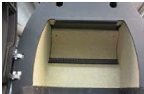
22 Wszystkie płyty komory spalania zostały zamontowane
